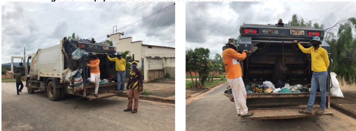
Figura 32 - Equipe de coleta de resíduos sólidos comuns de Montalvânia
