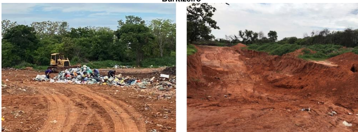
Figura 54 - Presença de catadores (à esquerda), material de recobrimento dos resíduos (à direita) de Buritizeiro
