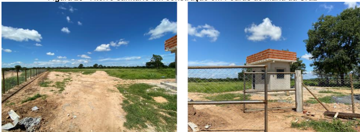
Figura 20 - Aterro sanitário em construção em Pedras de Maria da Cruz
