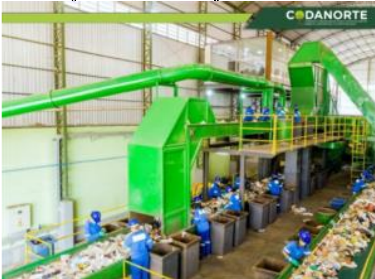
Figura 8 – Modelo de Usina de Triagem mecanizada – UTM
