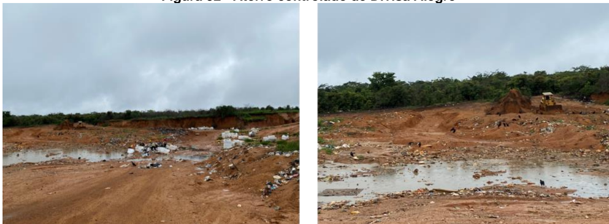
Figura 92 - Aterro controlado de Divisa Alegre
