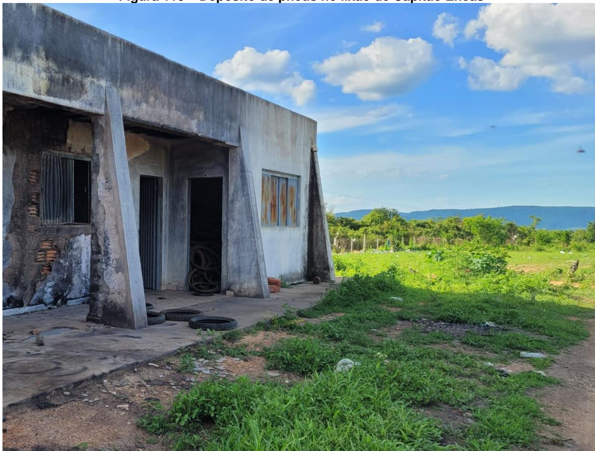
Figura 110 – Depósito de pneus no lixão de Capitão Eneas
