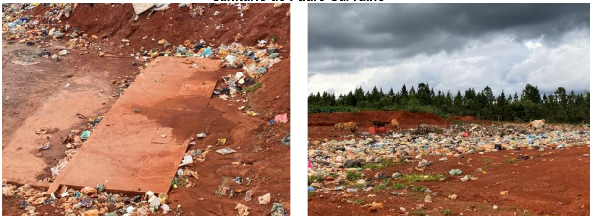
Figura 95 - Caixa de tratamento de efluentes líquidos (esq.) e presença de animais (dir.) no aterro sanitário de Padre Carvalho
