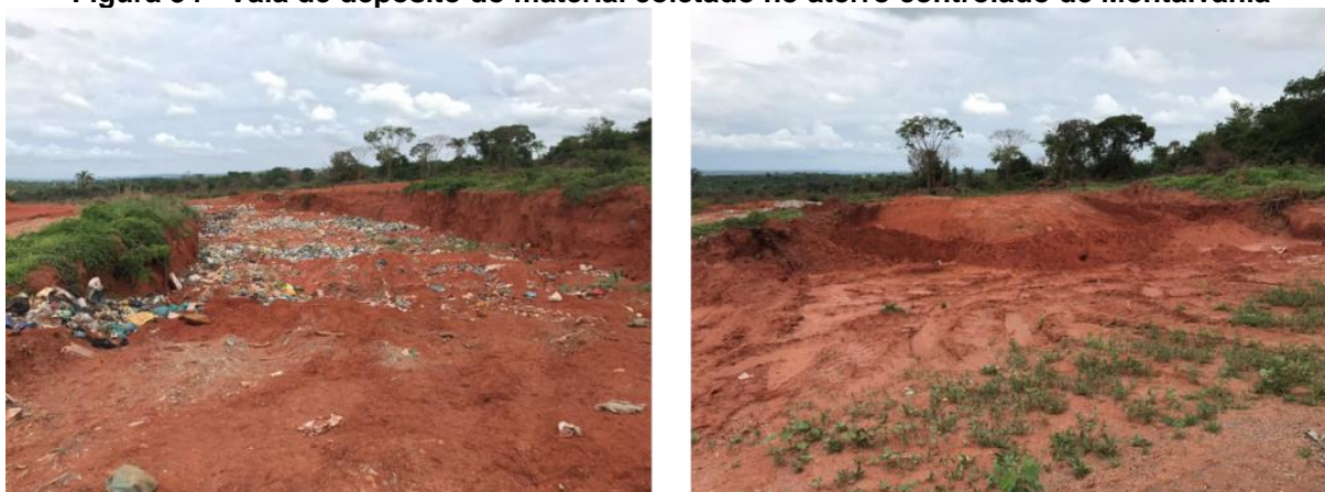
Figura 34 - Vala de depósito do material coletado no aterro controlado de Montalvânia
