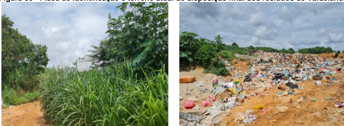
Figura 66 - Placa de identificação e terreno atual de disposição final dos resíduos de Varzelândia
