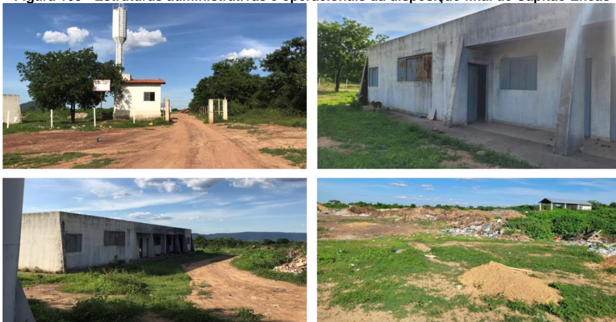
Figura 105 - Estruturas administrativas e operacionais da disposição final de Capitão Eneas
