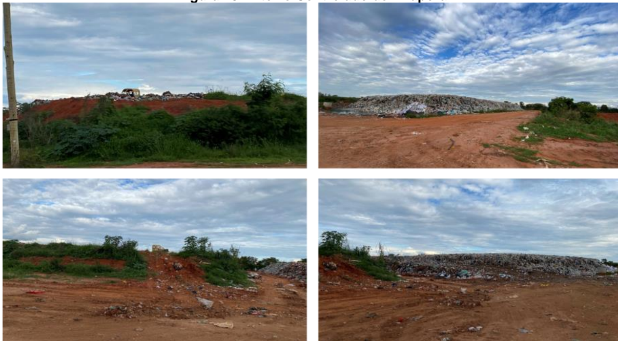
Figura 45 - Aterro Controlado de Pirapora
