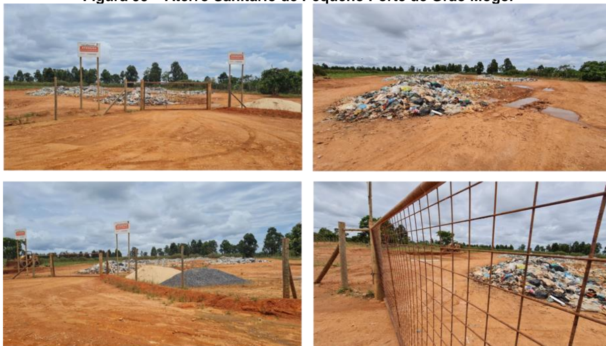
Figura 95 – Aterro Sanitário de Pequeno Porte de Grão Mogol
