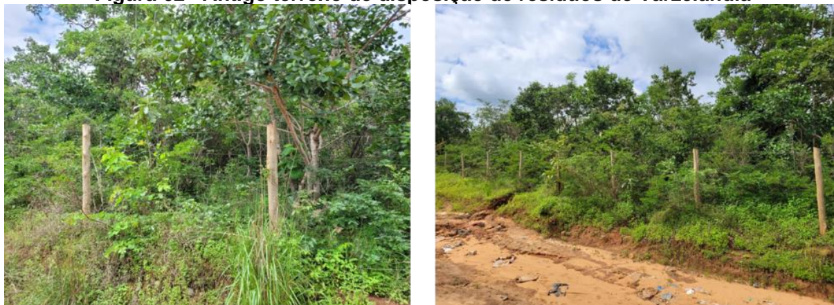
Figura 62 - Antigo terreno de disposição de resíduos de Varzelândia
