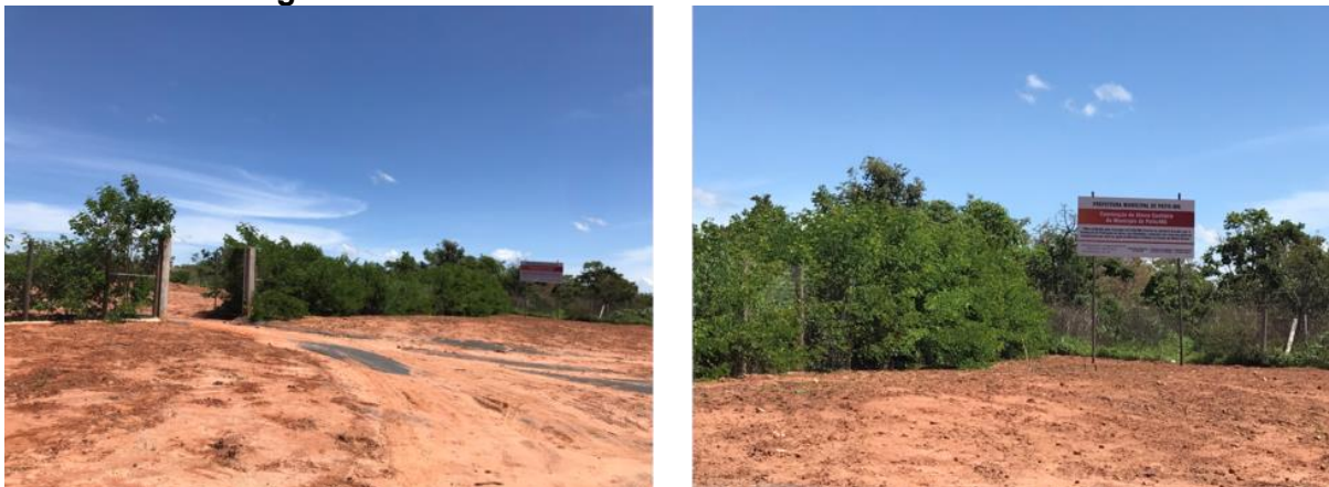
Figura 119 - Aterro Sanitário em licenciamento de Patis
