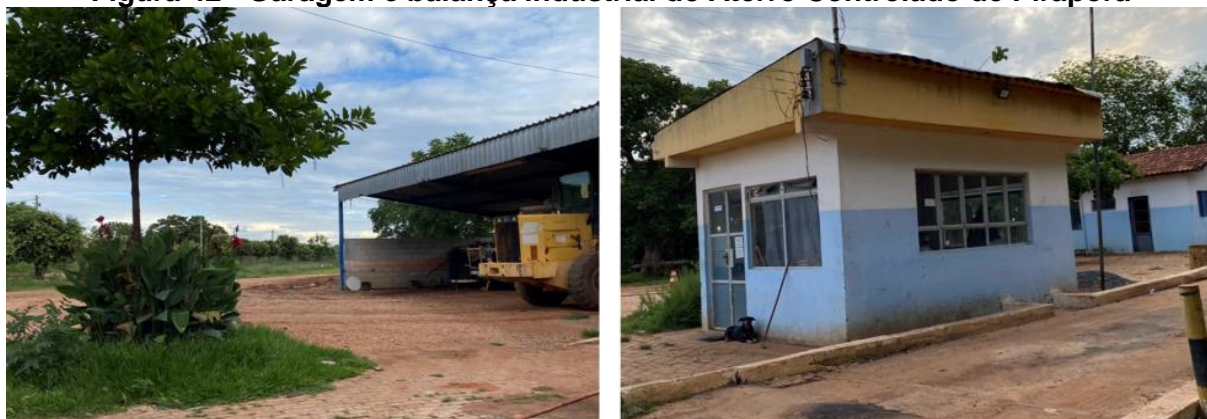
Figura 42 - Garagem e balança industrial do Aterro Controlado de Pirapora
