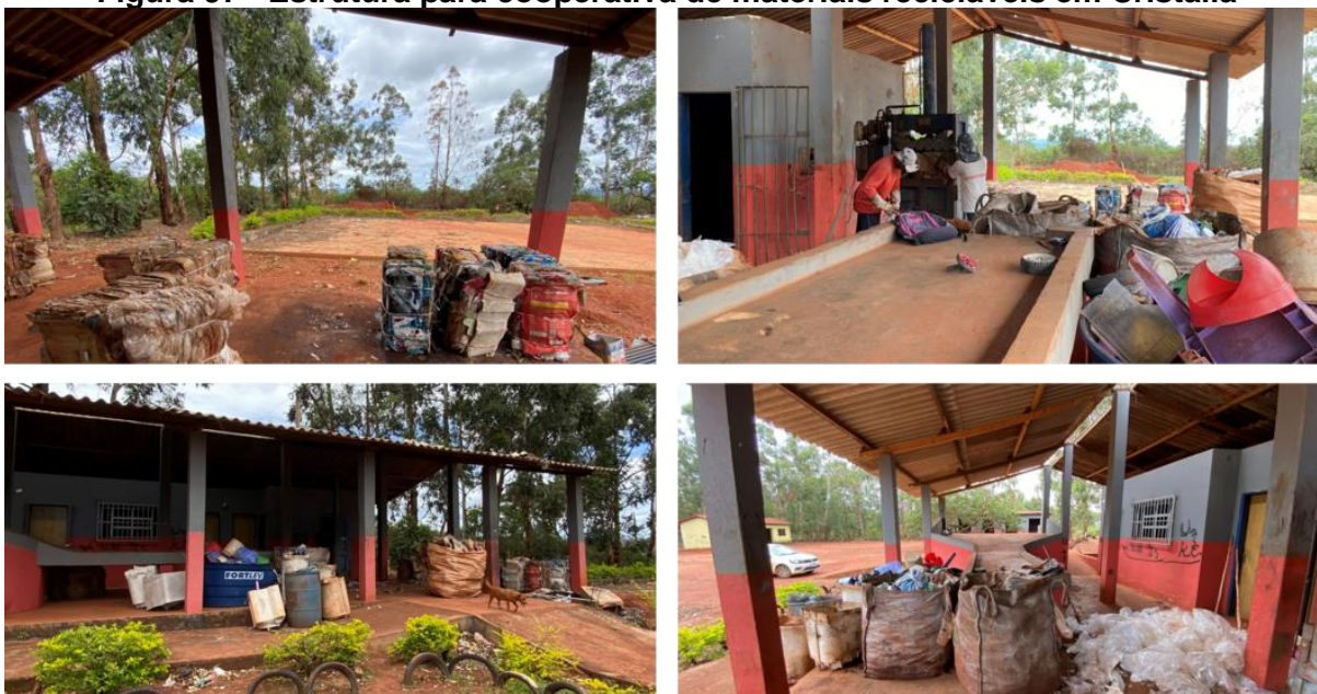
Figura 97 - Estrutura para cooperativa de materiais recicláveis em Cristália
