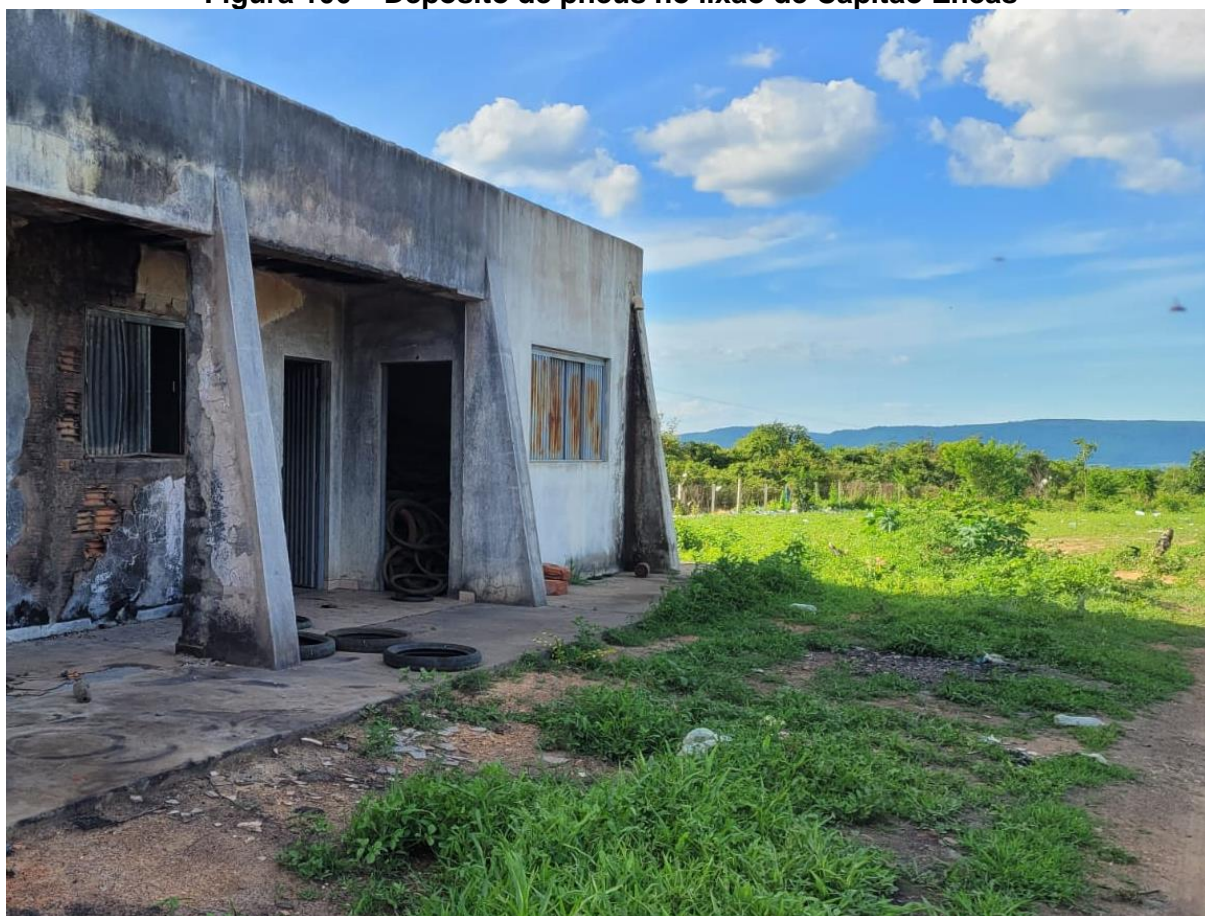
Figura 106 – Depósito de pneus no lixão de Capitão Eneas
