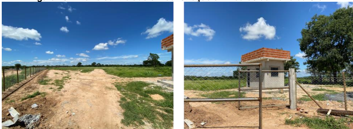
Figura 19 - Aterro controlado em construção em Pedras de Maria da Cruz
