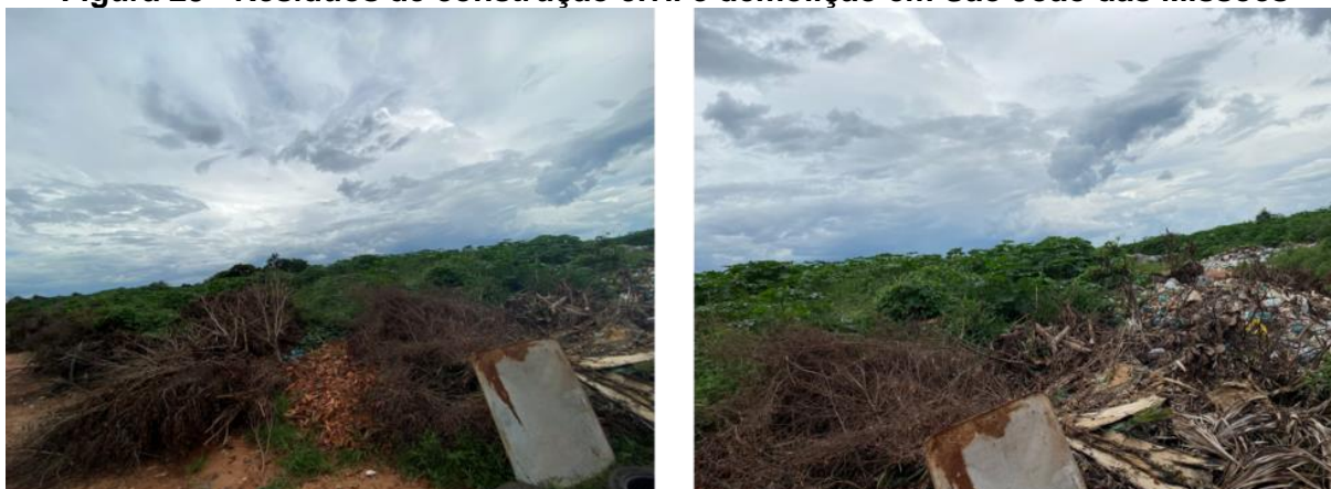
Figura 23 - Resíduos de construção civil e demolição em São João das Missões
