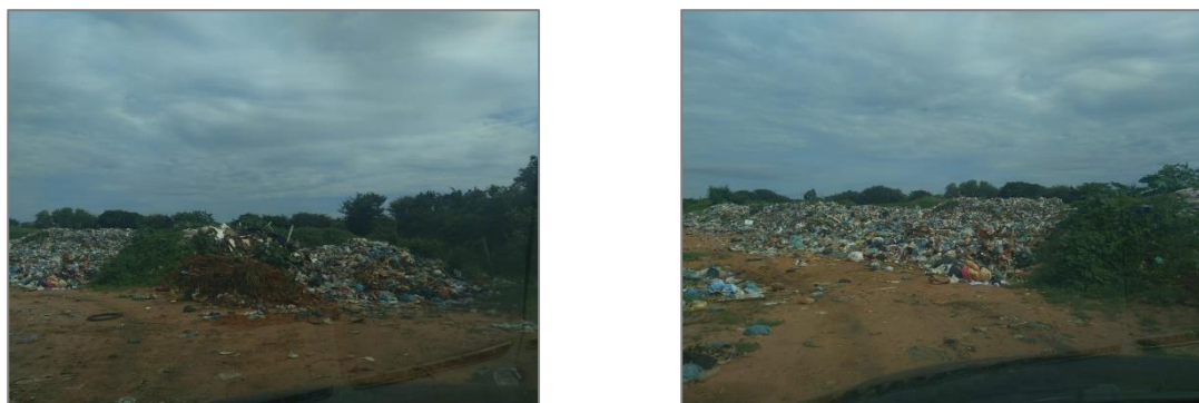
(a) Área de destinação final de resíduos
