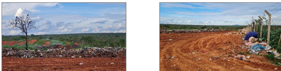
(a) Área de destinação final de resíduos
