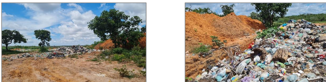
(a) Área de destinação final de resíduos
