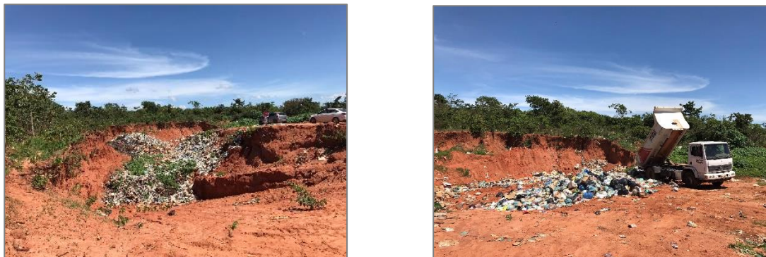
(a) Área de destinação final de resíduos
