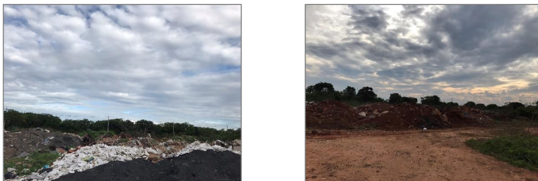
(a) Área de destinação final de resíduos
