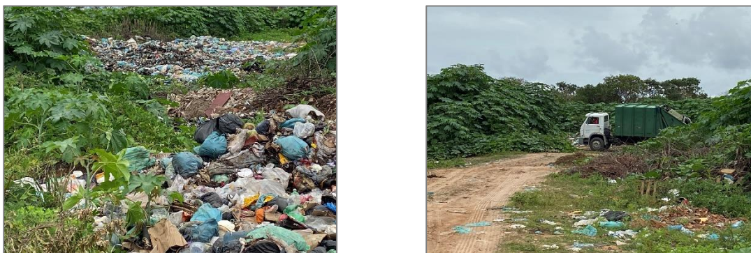
(a) Área de destinação final de resíduos
