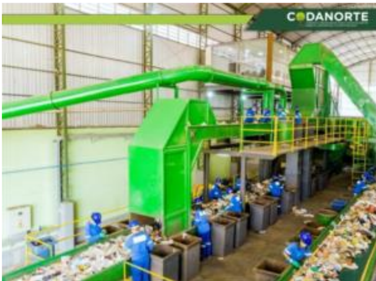
Figura 8 – Modelo de Usina de Triagem mecanizada – UTM
